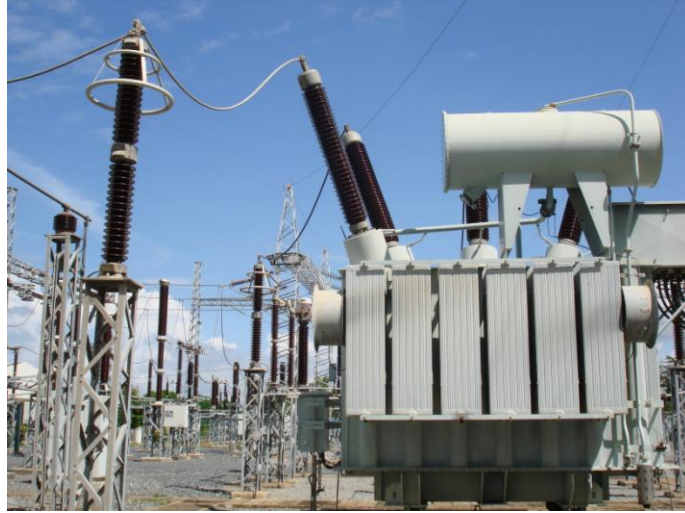
Hình 2.3 Các bộ phận bên ngoài của máy biến áp
