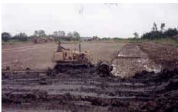
Hình 2.14: Xây dựng ao nuôi bằng máy ủi (Nguồn: Vuong, 2001)
