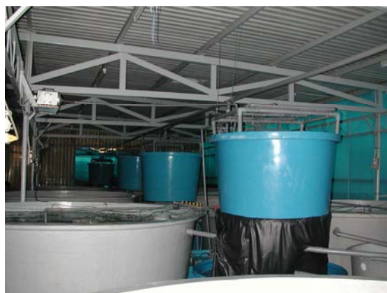
Hình 2.11: Hệ thống ương ấu trùng hở/thay nước (trái) và kín/lọc tuần hoàn (phải)
